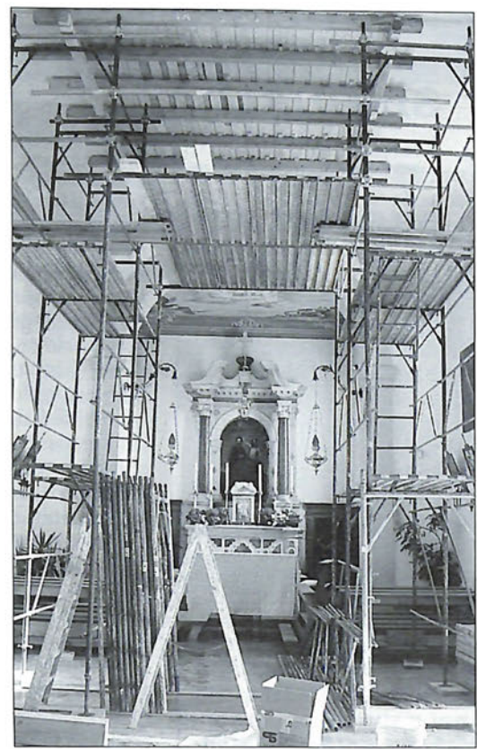
Le impalcature di sostegno del soffitto: la "sicurezza" viene realizzata da sopra.
