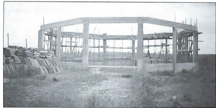
Ossatura di una chiesa ottagonale, a discesa di platea, per una parrocchia di Castanhal, diocesi di Belem, stato federale del Parà, nel Nord-Est del Brasile. L'ha scattata, il 20 novembre 2002, don Giovanni Belli, che ne è anche l'architetto e il maestro costruttore.
