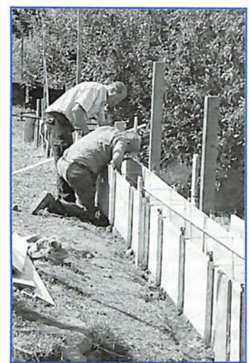
Il Gruppo Alpini ha fatto il muro di recinzione del cortile. Grazie!
